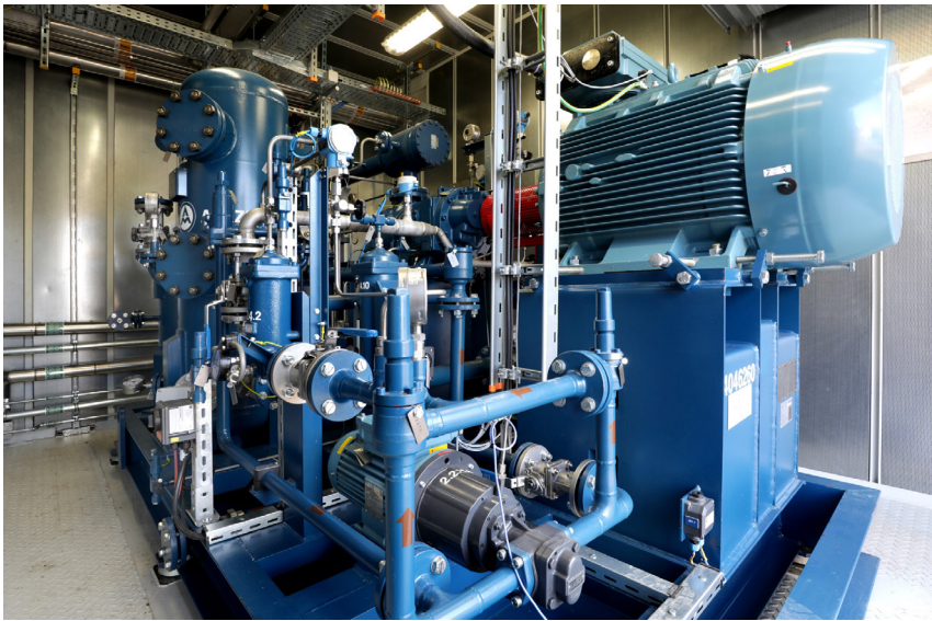
Biogas-getriebenes Blockheizkraftwerk in der RMB | © FES GmbH
