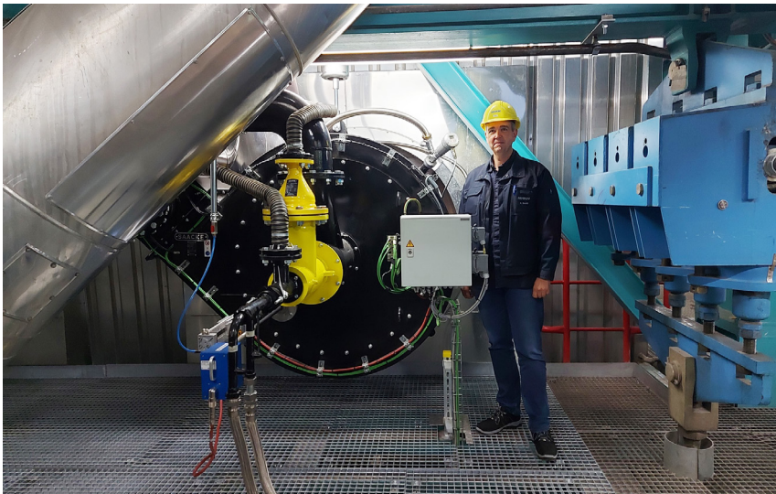
Projektleiter Frank Senft neben einem der neuen wasserstofffähigen Brenner | © FES GmbH
