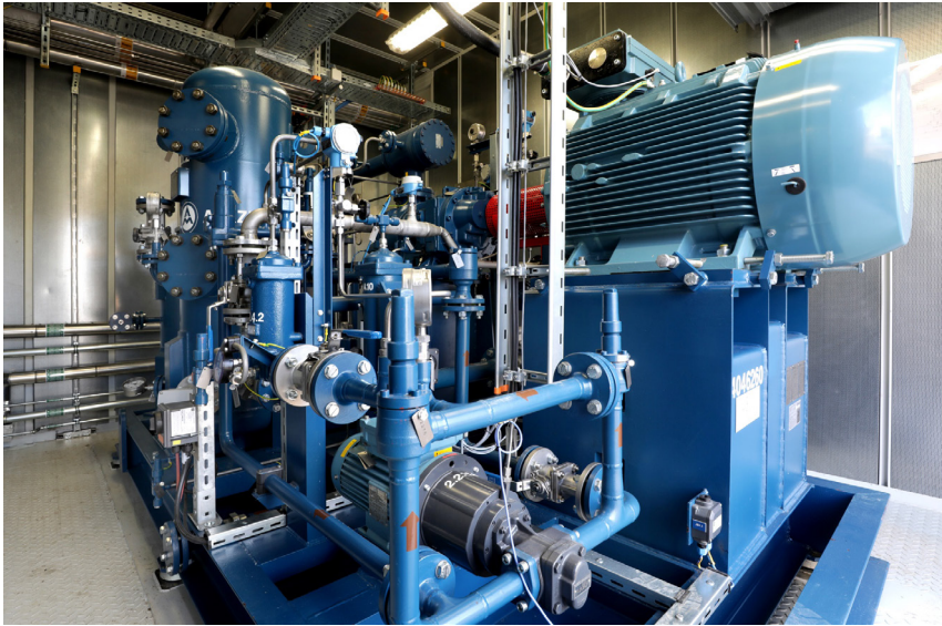
Biogas-getriebenes Blockheizkraftwerk in der RMB | © FES GmbH
