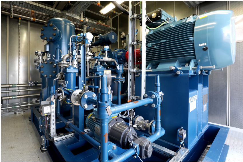
Biogas-getriebenes Blockheizkraftwerk in der RMB | © FES GmbH
