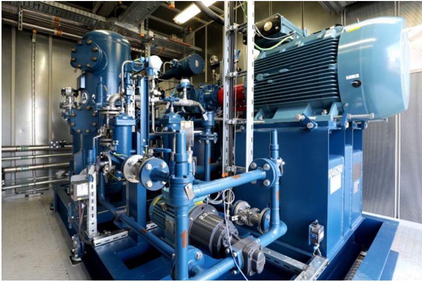
Biogas-getriebenes Blockheizkraftwerk in der RMB | © FES GmbH
