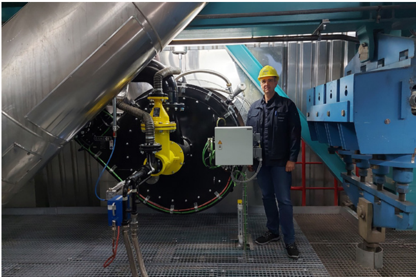
Projektleiter Frank Senft neben einem der neuen wasserstofffähigen Brenner | © FES GmbH
